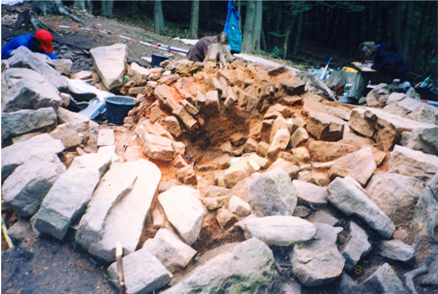
Freigelegter Feuerungskanal, dahinter die Brennkammer.
