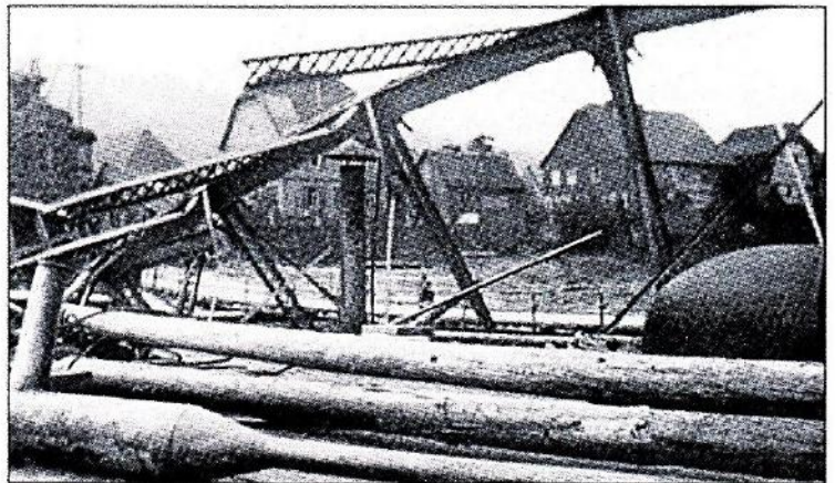
Die von deutschen Verteidigern kurz vor Anrücken der Amerikaner gesprengte Weserbrücke (daneben eine Notbrücke) bei Gieselwerder wurde fünf Jahre später neu gebaut. Die darin ebenfalls in den Pfeilern enthaltenen Sprengkammern wurden erst 2014 zubetoniert. Repro: zta
