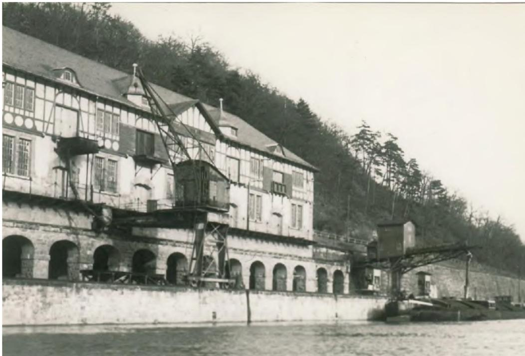
Oben: Weserumschlagstelle Hann. Münden in den 1950er Jahren mit Lagerhaus, elektrischem Kran für Stückgut und Verladeanlage für Kali und Schüttgut.
